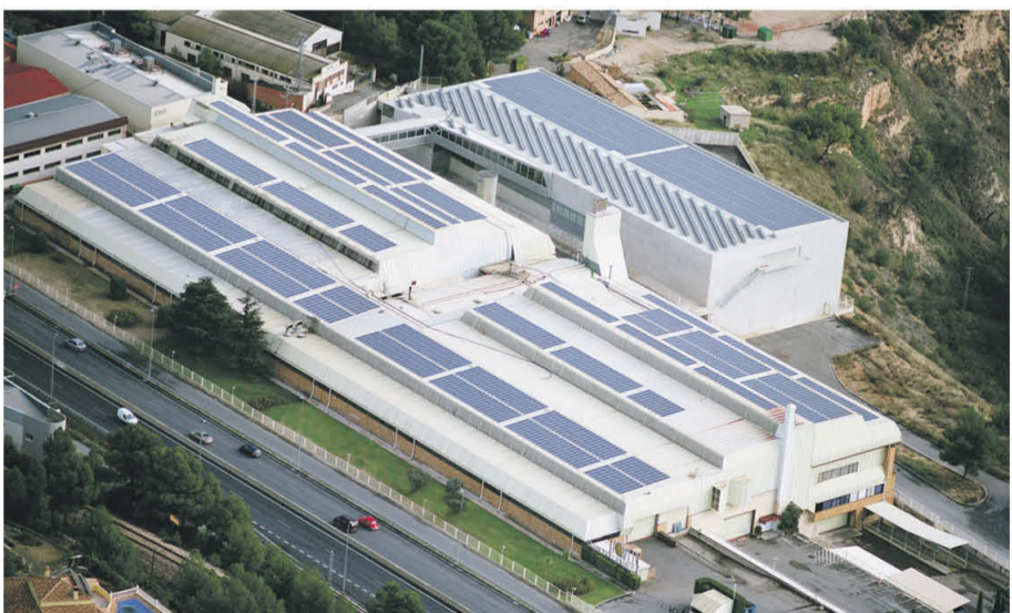
• Grupo Jover / 601,15 kWp
